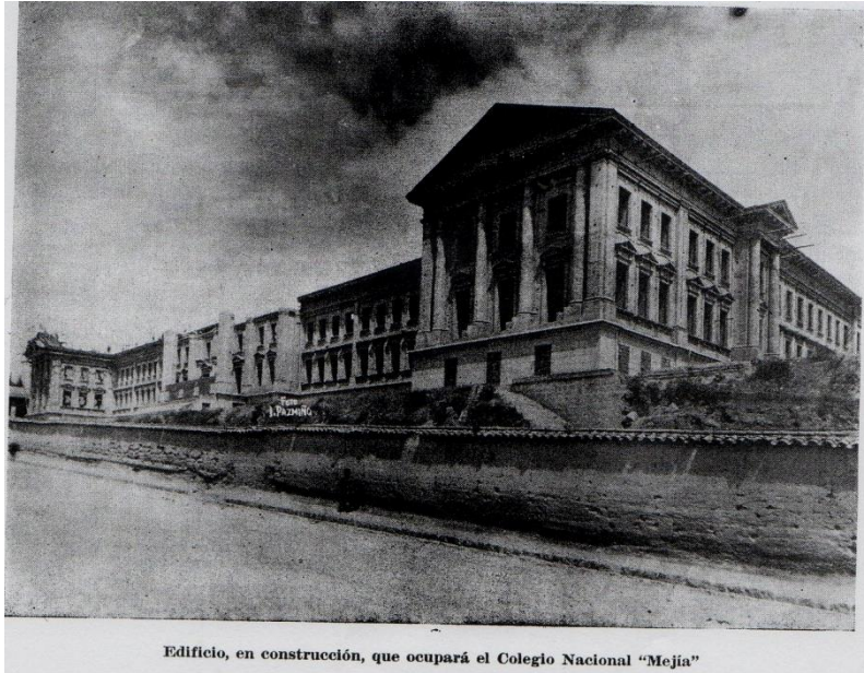
Ilustración 13: “Edificio, en construcción que ocupará el Colegio Nacional ‘Mejía’”
