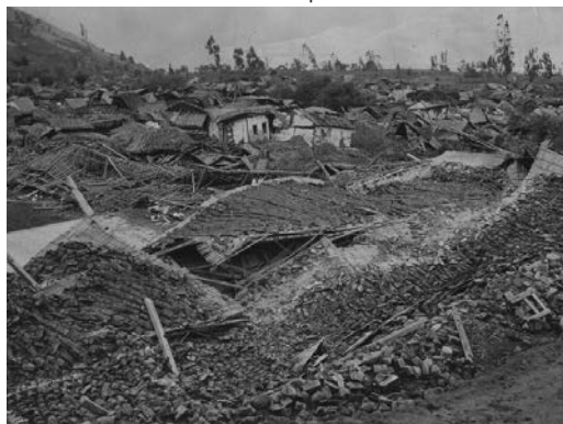
Foto 1. Pelileo días después del terremoto
