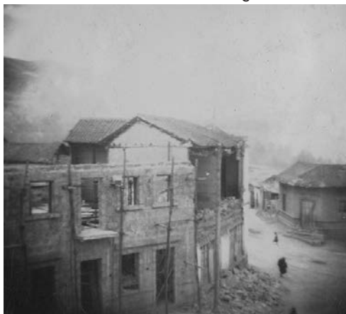
Foto 2. Edificaciones de Ambato luego del terremoto
