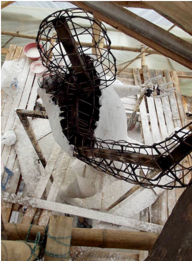
Fotografía 7 Aplicación de capa interna de yeso (vista lateral derecha)
