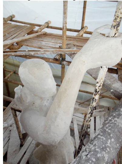
Fotografía 8 Aplicación de capa interna de yeso (vista posterior superior)
