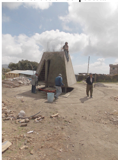
Fotografía 36 Construcción del pedestal
