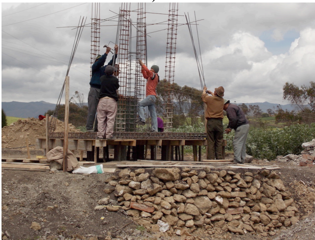
Fotografía 35 Construcción del pedestal (estructura interna)
