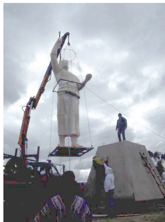
Fotografía 34 Movilización con grúa hacia el pedestal
