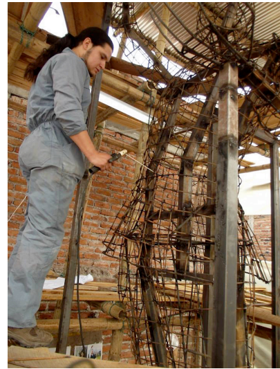
Fotografía 6 Construcción de estructura metálica
