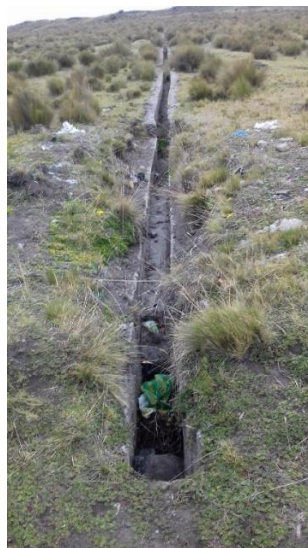
Figura 32. Canales fuera de servicio en la comunidad de Cunucyacu Fuente: Archivo personal. David Hidalgo 2020 Elaboración propia
